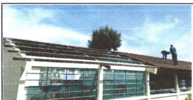
Foto 5: CUBIERTA DE LAMINA AULAS #3, #4, LIBRERIA Y DIRECCION.
