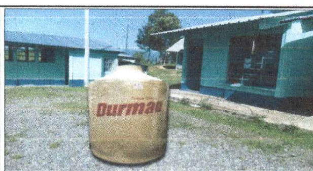
Foto 6: SUSTITUCION DE DEPOSITO DE AGUA DE 1000 LT.
