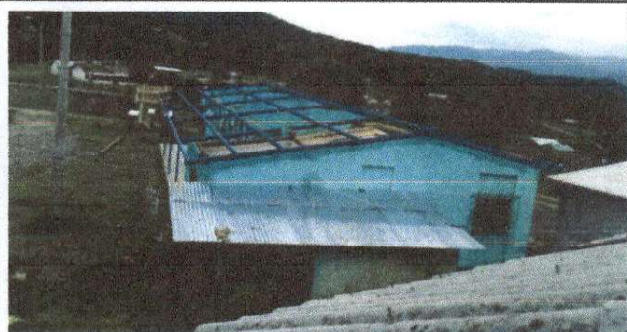
Foto1: INSTALACION DEL TECHO DE LA ESCUELA OFICIAL RURAL MIXTA DE ALDEA CANOJ
